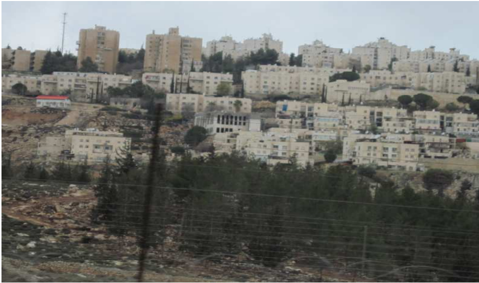
شكل 16.4: جزء من مستوطنة (بسغات زئيف). المصدر: (الباحث، 2010).
