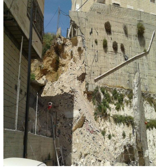
صورة (54) عدم وجود جدار استنادي
