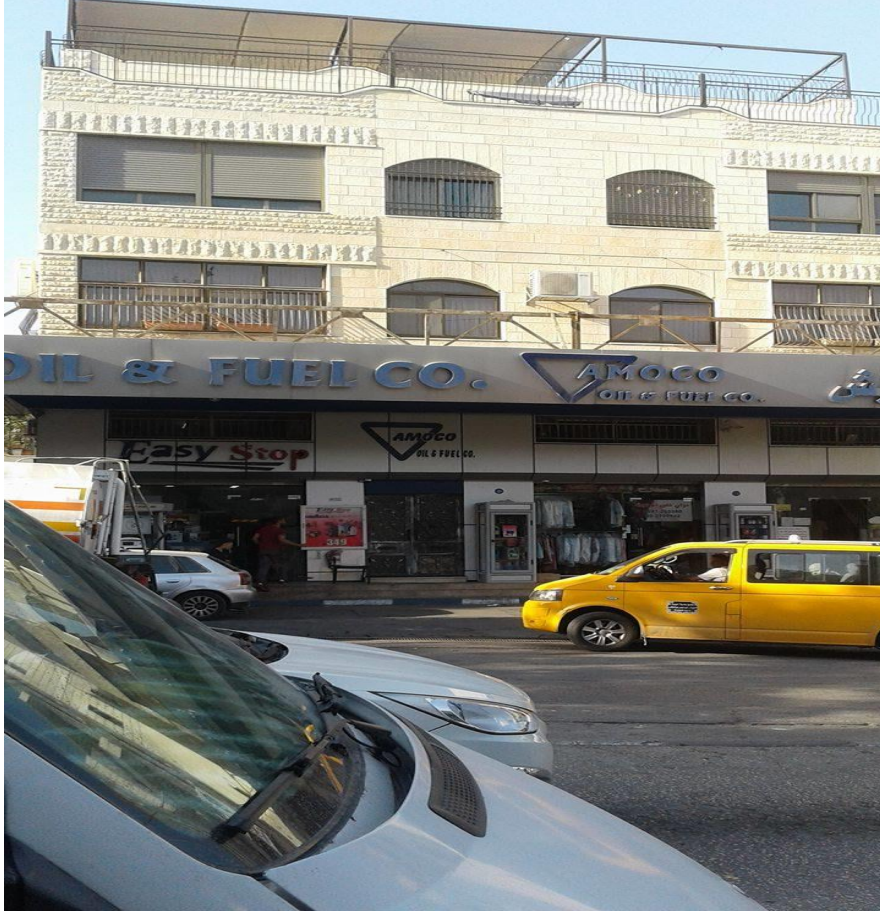
صورة (42) محطة وقود داخل المباني
