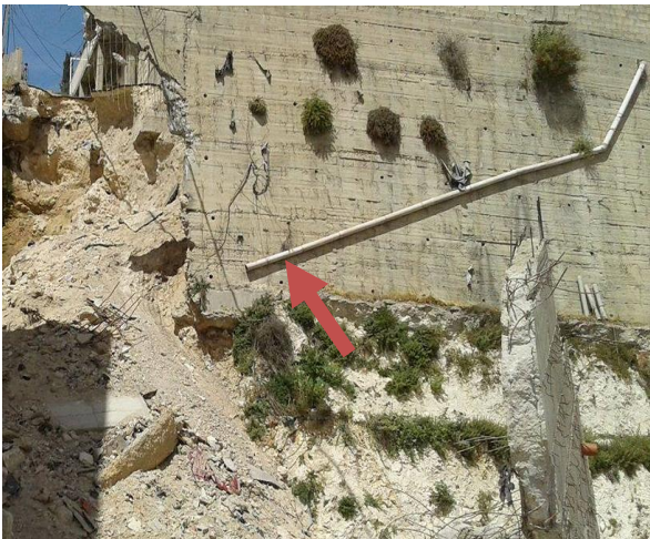
صورة (44) مجاري بالقرب من المباني
