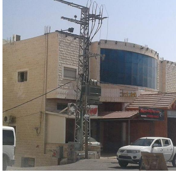
صورة (38) المحول قريب من البناء بشكل كبير
