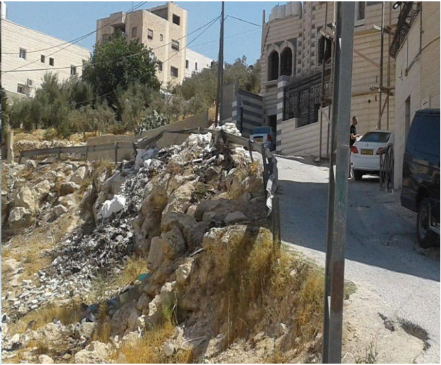
صورة (31) نفايات بجانب الشارع
