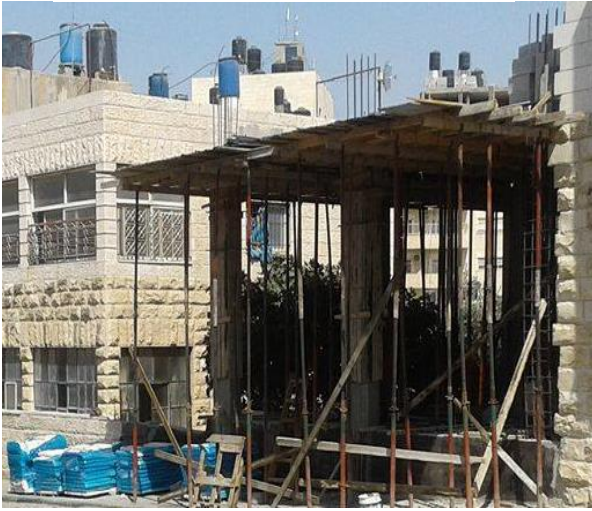
صورة (10) سقالات البناء على الشارع
