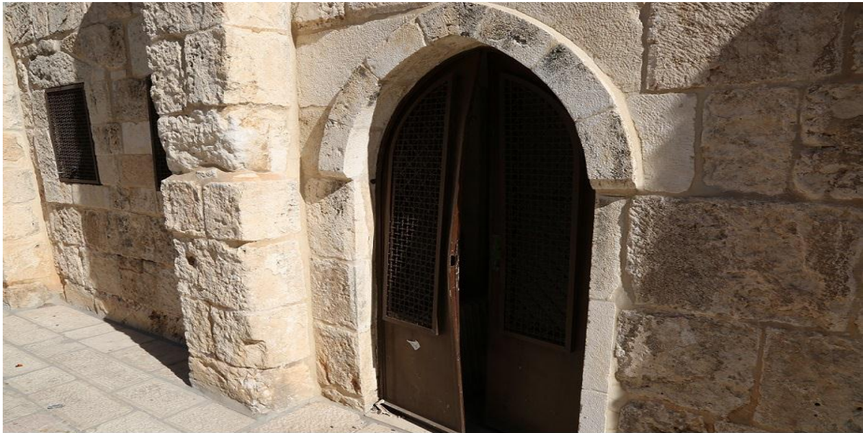
صورة 14: اثار الخراب الذي خلفته قوات الهندسة اثناء اغلاق المسجد الأقصى المبارك وإفراغه من موظفي وحراس المسجد التاريخ: 3.8.2017 المصدر: دائرة اوقاف القدس وشؤون المسجد الأقصى المبارك
