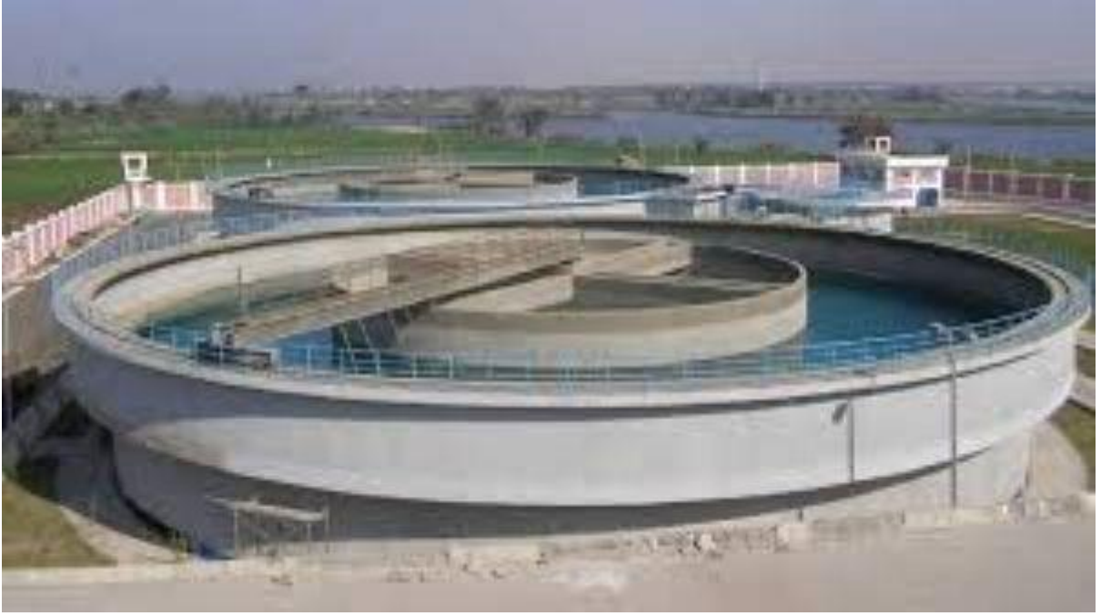
صورة لمحطة تنقية المياه العادمة في مدينة نابلس
