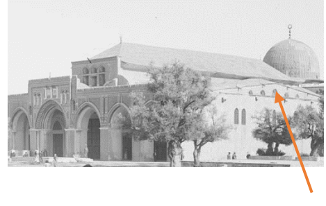
لوحة رقم 91: الأقصى في السنوات 1898م ، وتظهر في اللوحة نوافذ المستوى الثالث الغربية ، تهدمت نتيجة الزلزال وتم تغيير شكل السقف وإغلاق النوافذ. مصدر اللوحة: https://2u.pw/N3yoj1Q
