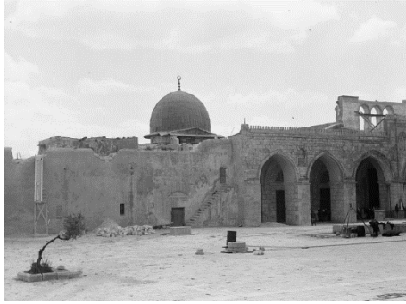
لوحة رقم 94: الجامع الأقصى في سنة 1934، ويظهر النمار الذي ألحقه الزلزال بالجامع الأقصى، ويلاحظ تهدم مبنى بيت النجارة. مصدر اللوحة: https://2u.pw/s9N9uDK
