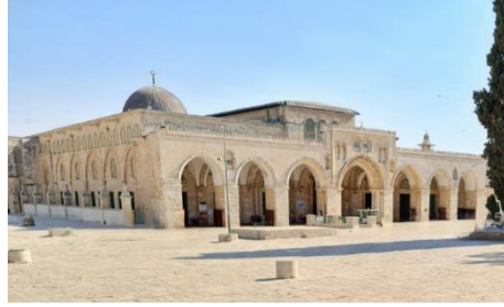
لوحة رقم 13 : الجامع الاقصى في القدس من الخارج ، تظهر النوافذ وهي على عدة ارتفاعات. مصدر اللوحة: الباحث
