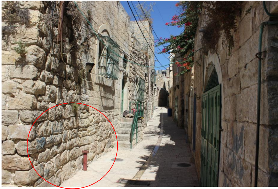
شكل 41.4: الواجهة المستهدفة بالدراسة إلى اليسار، ويظهر الاختلاف في طوبوغرافية الموقع وعدم ظهور الطبقات الأرضية للجزء الجنوبي منها. المصدر: الباحث، 2017
