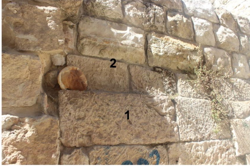
شكل 7.2: كيفية تمييز طبقات المبنى من خلال الاختلاف في طريقة البناء، حيث يلاحظ التراجع عند بناء الطبقة رقم (2). المصدر: الباحث، 2016
