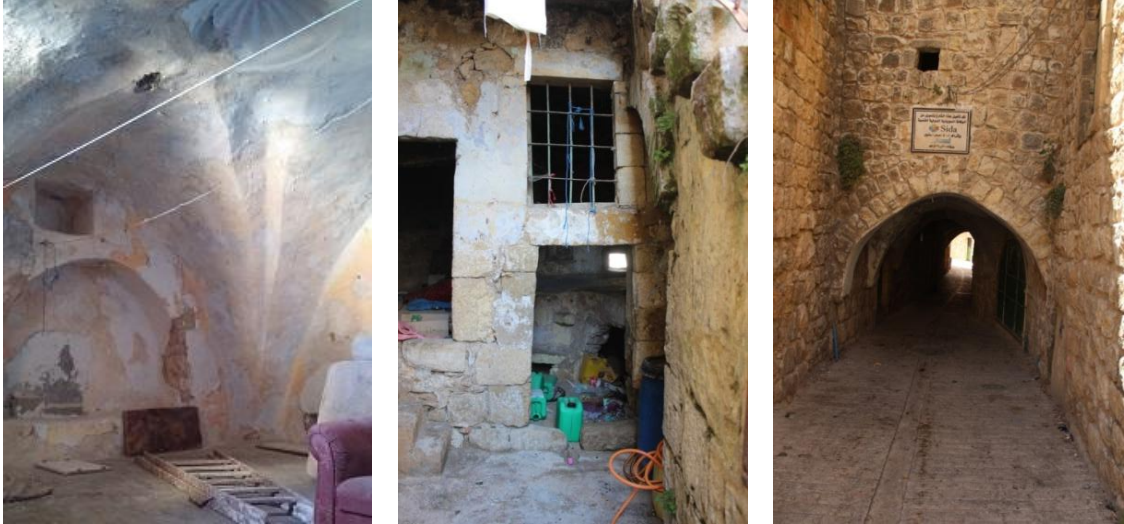
شكل 8.5: غرفة القنطرة من الخارج والداخل.
