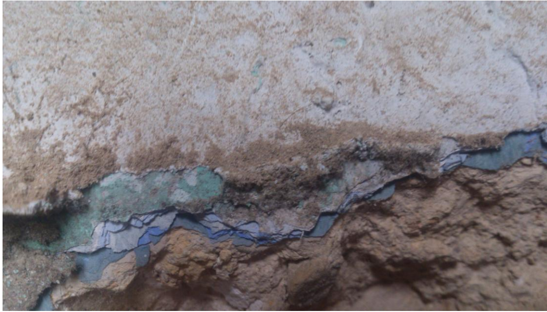
شكل 2.2: طبقات الطراشة الدالة على فترات الاستخدام للمبنى.
