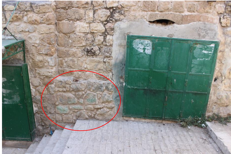
شكل 41.5: تحويل الشباك إلى باب محل تجاري وبناء جدار يربط الكتلتين. المصدر: الباحث، 2017
