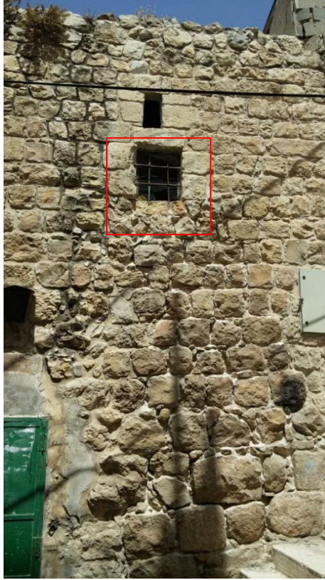
شكل 42.5: عملية توسيع الشباك. المصدر: الباحث، 2017
