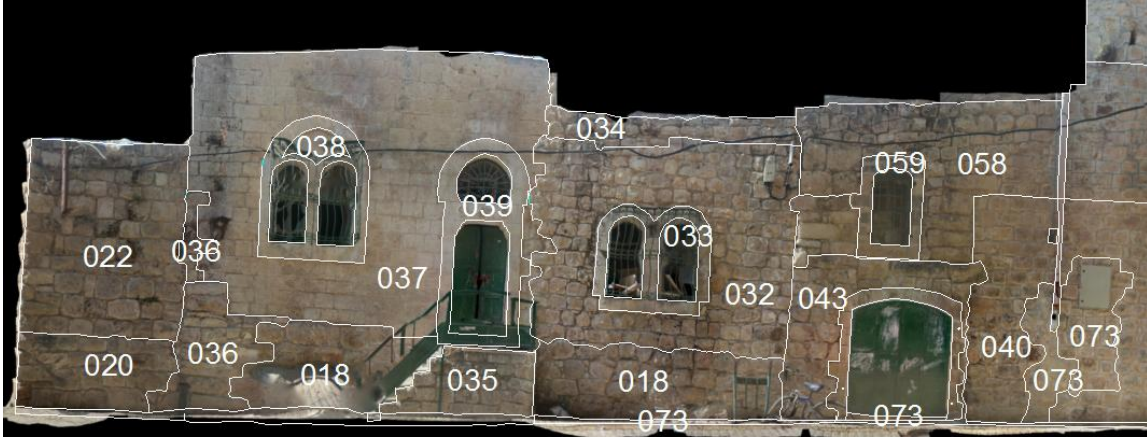
شكل 48.5: الوحدات الطباقية في الواجهة الشمالية.
