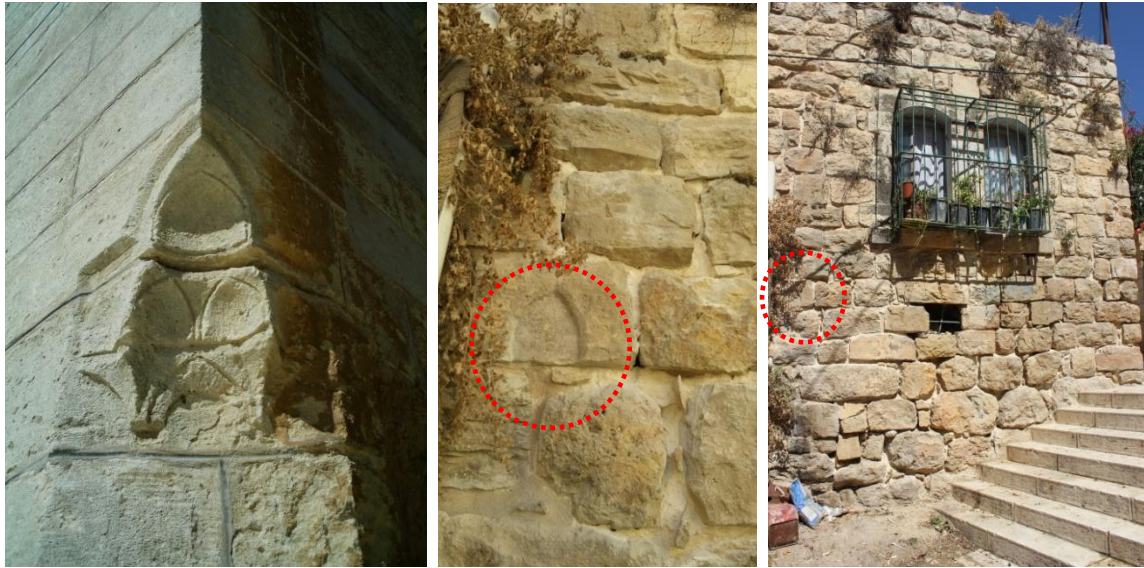
شكل 39.5: قطعة حجرية على شكل مقرنص تم إعادة استخدامها إلى اليمين أعلاه موقع القطعة الحجرية، وفي الوسط تفصيلة المقرنص، فيما تظهر الصورة إلى اليسار المقرنصات المشابهة في بوابة منارة زاوية الشيخ علي البكاء. المصدر: الباحث، 2017
