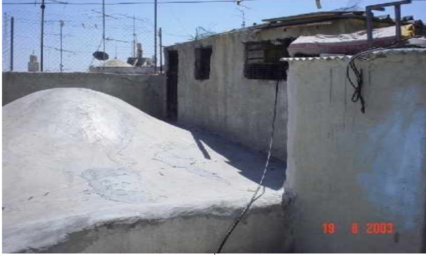
شكل 34.6: شكل لسطح المبنى قبل الترميم المصدر: جمعية القدس للرفاه والتطوير
