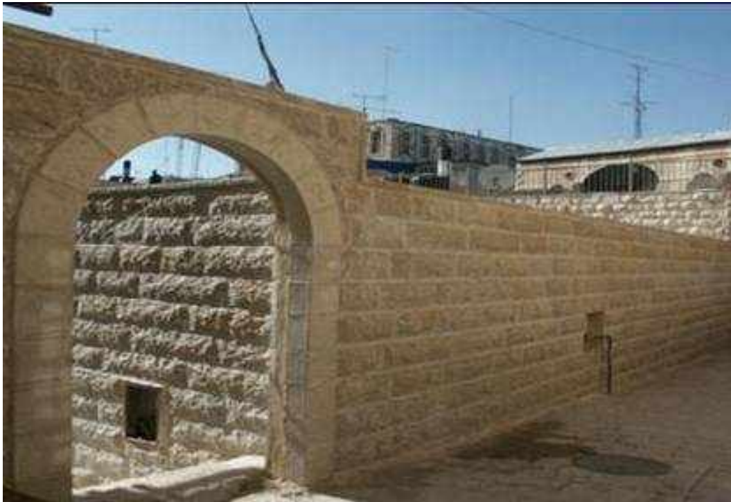
شكل 20.5: شكل لنفس الواجهة بعد ترميمها من قبل مجلس الإسكان حيث يبدو تلبس جميع الواجهات الخارجية بحجر جديد إضافة إلى بناء إضافات حديثة داخل الحوش، عام 2006.
