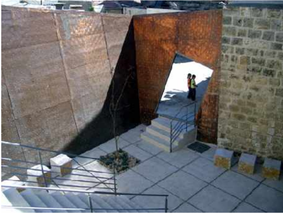
شكل 3.5: مشروع الكمنجاتي في رام الله الذي تم ترميمه من قبل المركز، والذي تم فيه استخدام عنصر النحاس لبناء واجهة المدخل الرئيسي
