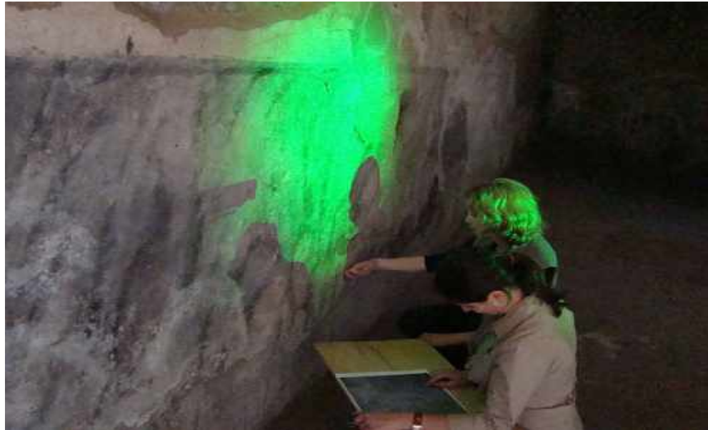
شكل 7.6: فحص الفراغات خلف القصارة باستخدام الليزر
