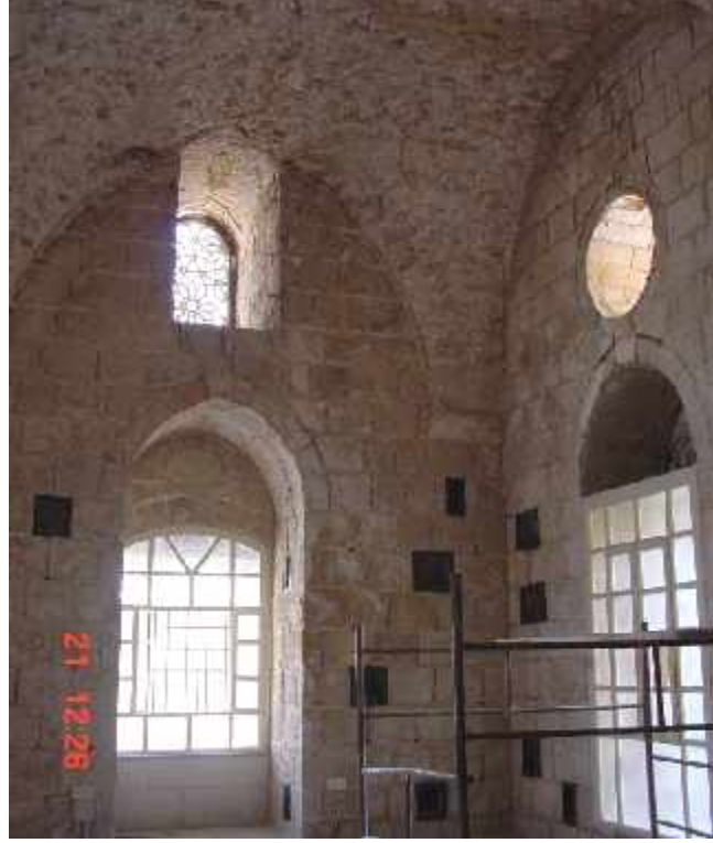
شكل 15.6: تجفيف المبنى من الرطوبة و آثار مياه الأمطار من الداخل وتشمل إزالة القصارة الإسمنتية، إزالة بعض الحجارة بشكل مؤقت، تحرير الحول بين مداميك الحجارة وفتح الأبواب و الشبابيك لزيادة التهوية الطبيعية. المصدر: مؤسسة التعاون
