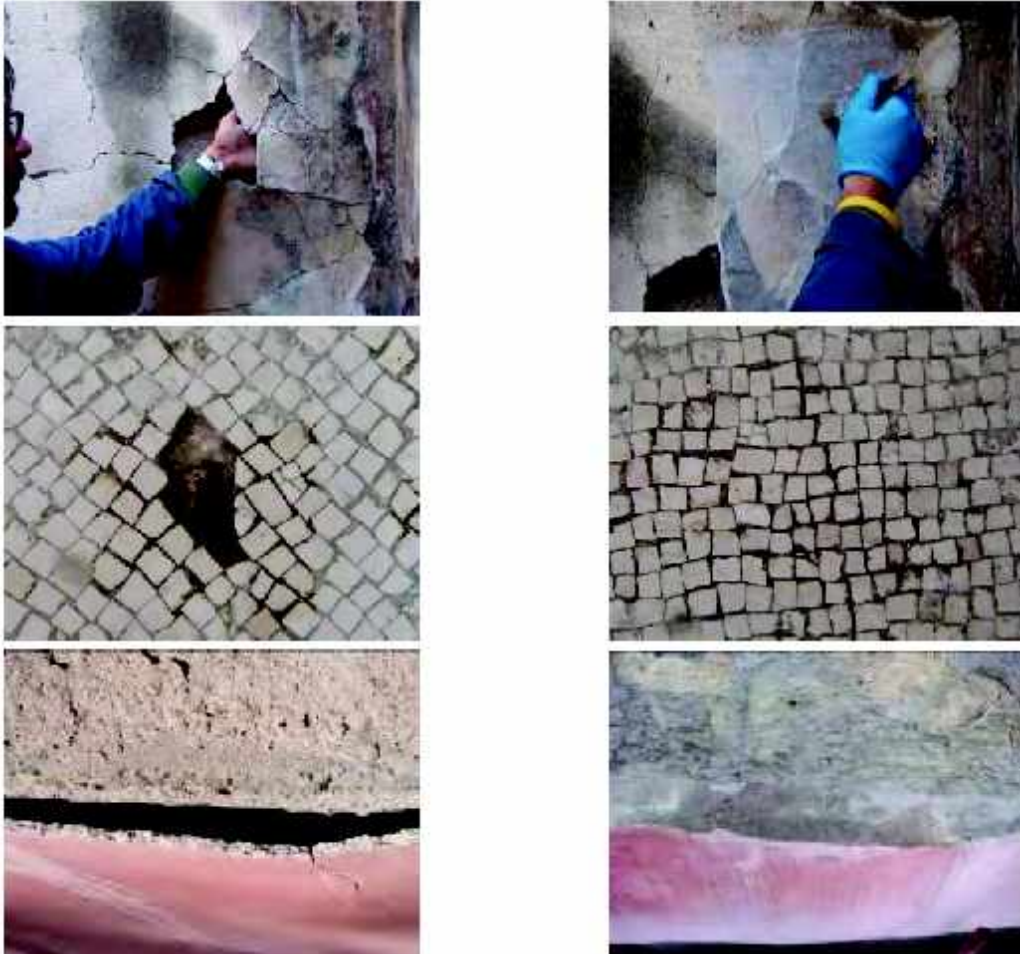
شكل 10.6: المحافظة على القصارة وتقويتها وتثبيتها باستخدام مواد قابلة للإرجاع (reversible).
