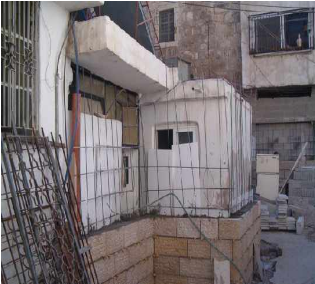
شكل 29.6: شكل للإضافات الخرسانية التي بنيت بحجر جديد.
