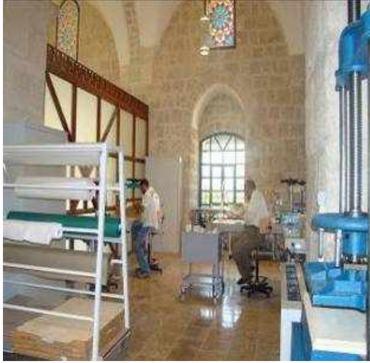
شكل 16.6: منظر داخلي للمبنى بعد الترميم المصدر: مؤسسة التعاون
