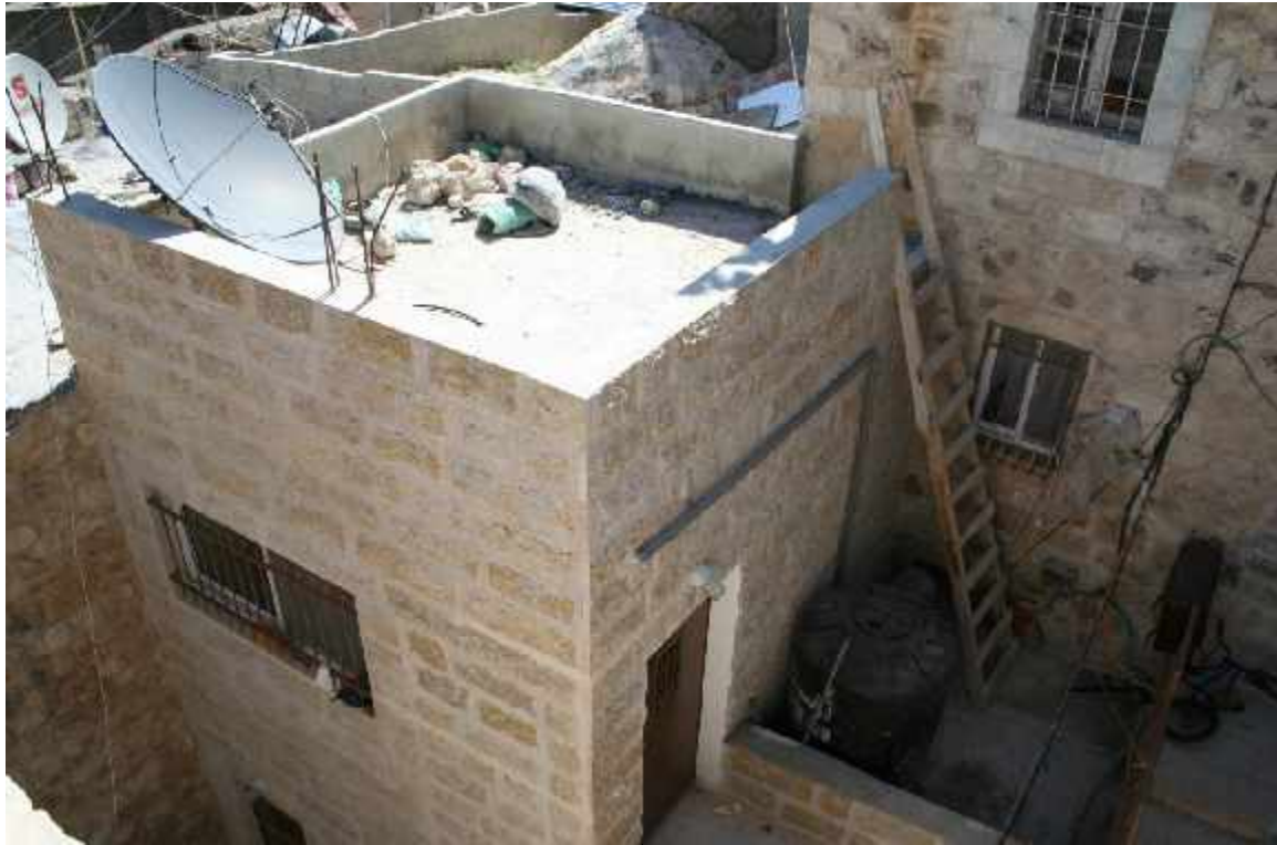
شكل 17.5: شكل لنفس المنزل بعد أن تم ترميمه من الخارج من قبل جمعية الرفاه والتطوير عام 2005 المصدر: جمعية القدس للرفاه والتطوير
