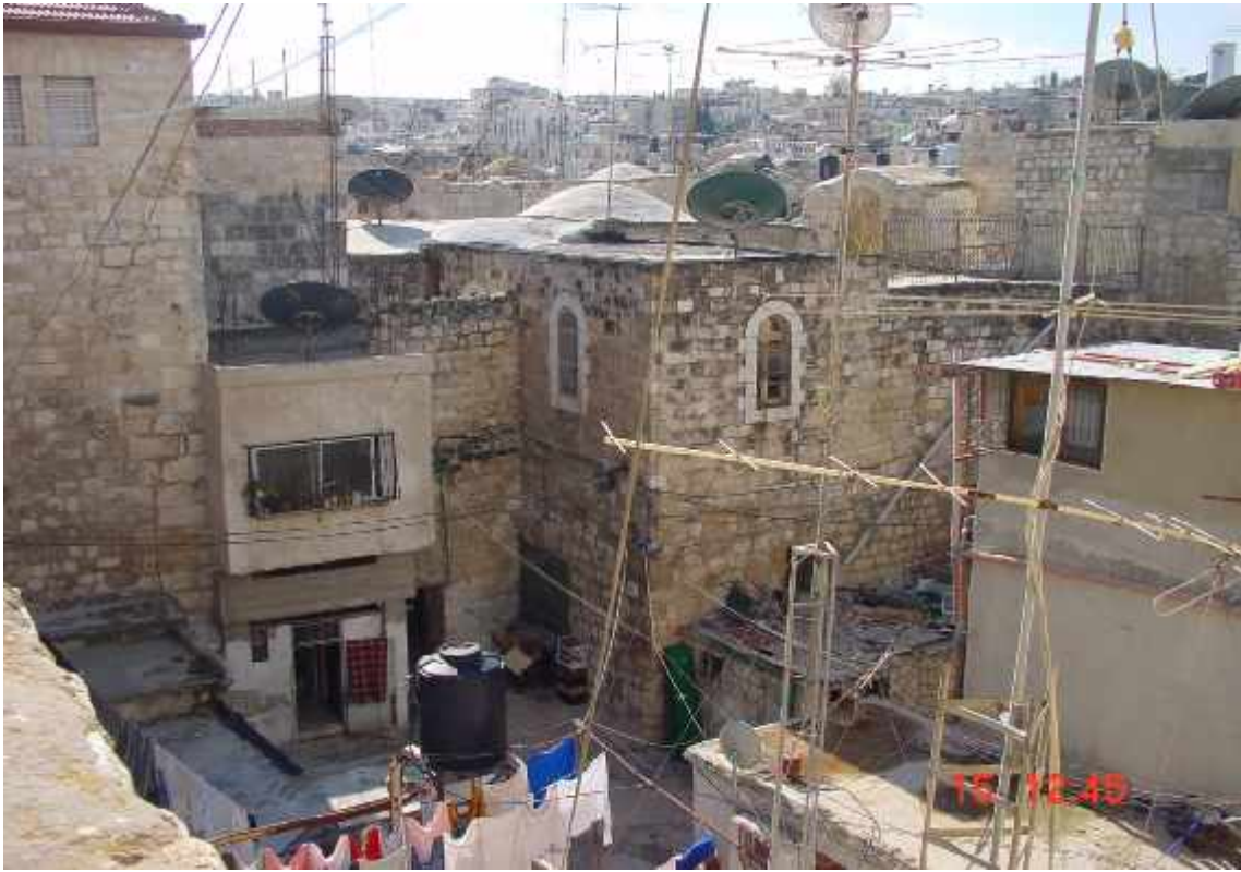
شكل 19.6: شكل عام لمشروع رباط علاء الدين البصيري قبل الترميم عام 2002
