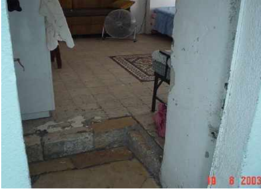
شكل 32.6: شكل لأرضية غرف عقار إبراهيم غيث المكونة من بلاط السجاد التقليدي عام 2003م المصدر: جمعية القدس للرفاه والتطوير
