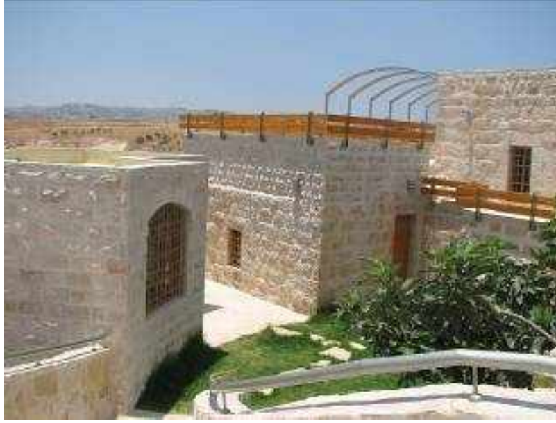
شكل 7.5: شكل لنفس لمشروع المبين في الصورة السابقة ولكن بعد الترميم المصدر:الباحث
