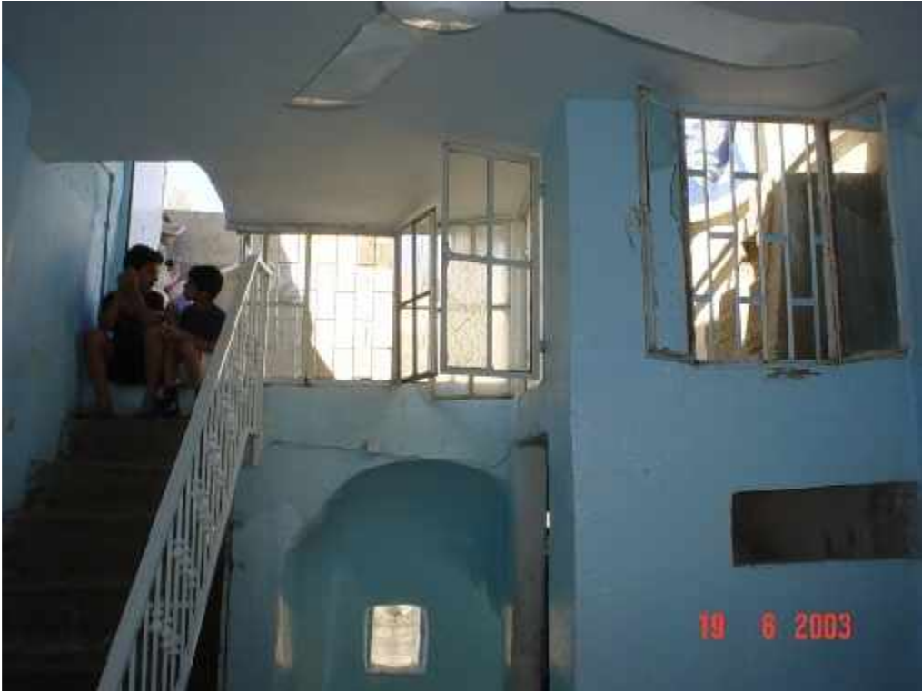
شكل 31.6: شكل من الداخل لعقار إبراهيم غيث قبل الترميم عام 2003 المصدر: جمعية القدس للرفاه والتطوير
