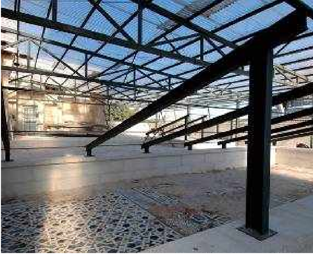
شكل 13.6: منظر للطابق العلوي للمدرسة وتغطية البلاط المملوكي بزجاج خاص يصد أشعة الشمس الضارة المصدر: مؤسسة التعاون (2004)
