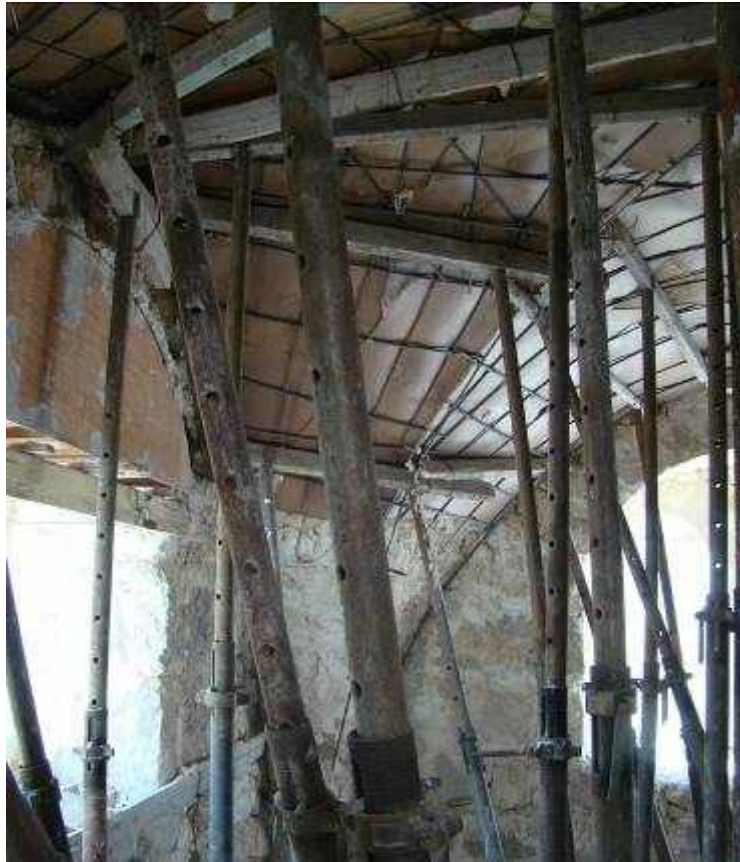
شكل 11.5: شكل يظهر استخدام الحديد المسلح لاعادة بناء السقف الذي تم هدمه لتوسيع الغرفة بهدف الاستفادة استخدامها كغرفة صفية في مبنى سيتم تحويله الى مدرسة. المصدر: الباحث عام 2008م
