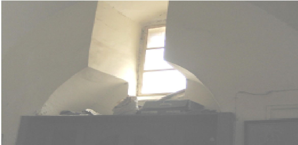
شكل 14.2: شكل لتغييرات في مكونات البناء القديم وذلك بازالة جزء من قوس السقف لاستيعاب خزانة الملابس المصدر: مؤسسة التعاون - عام 2008
