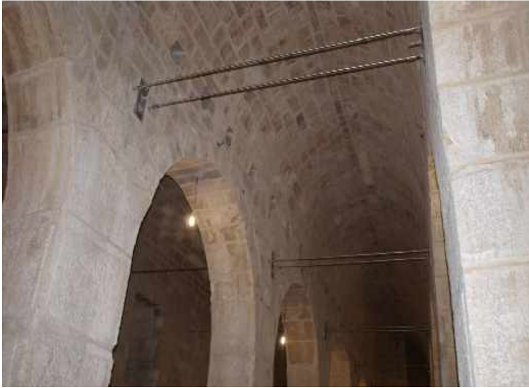
شكل 12.5: شكل يظهر تدعيم الجزء الجنوبي الشرقي من المصلى المرواني باستخدام القضبان المعدنية في عام 2004م. المصدر: الباحث، 2009
