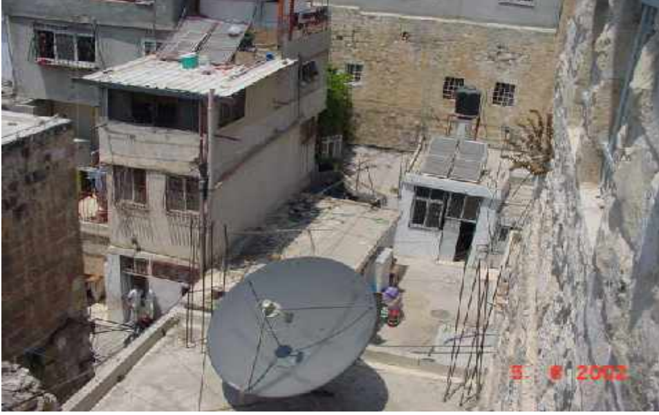
شكل 21.6 : شكل عام لمشروع ترميم رباط علاء الدين البصيري قبل الترميم عام 2002 المصدر: مؤسسة التعاون
