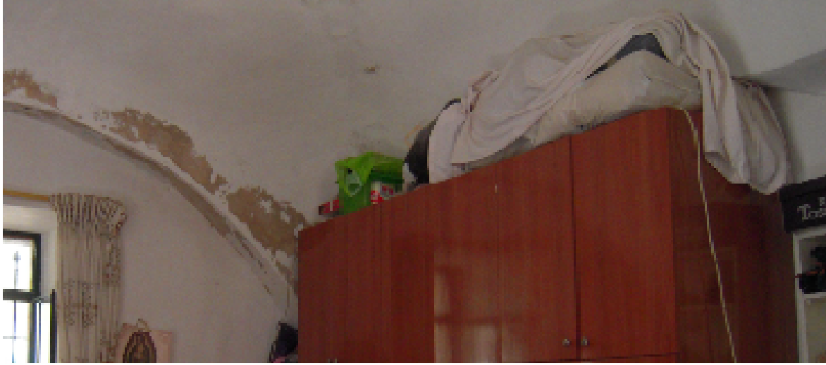
شكل 13.2: شكل لتغييرات في مكونات البناء القديم وذلك بازالة جزء من قوس السقف لاستيعاب خزانة الملابس المصدر: مؤسسة التعاون - عام 2008
