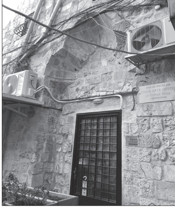
لوحة 1 الواجهة الجنوبية لرباط النساء
