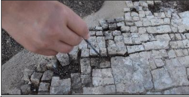
الشكل 4:96، عملية معالجة التشققات، خربة الطيرة. (المصدر): الباحث، 2016.
