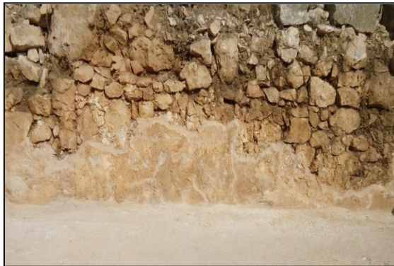
الشكل 105:4، طبقة القصاره بعد الترميم، الكنيسة الغربية، قرية الطيرة. (المصدر): الباحث، 2016.
