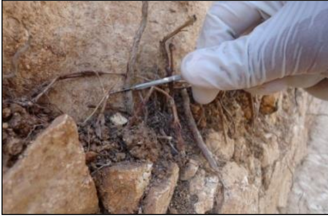
الشكل 71:4، معالجة النباتات بالطريقة الميكانيكية. (المصدر): الباحث، 2016.
