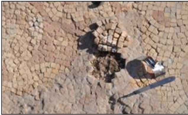
الشكل 4:77، اقتلاع المكعبات الفسيفسائية. (المصدر): الباحث، 2016.
