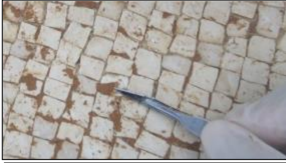
الشكل 4:87، تقنية التنظيف بالطريقة الميكانيكية. (المصدر): الباحث، 2016.
