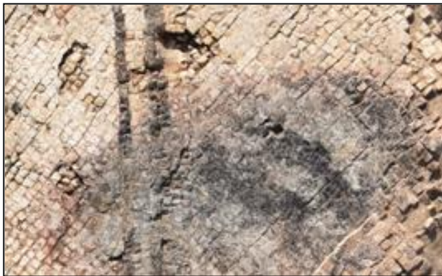
الشكل 4:89، التباين اللوني بسبب الحريق، خربة الطيرة. (المصدر): الباحث، 2016.
