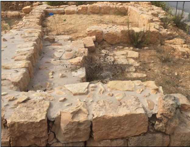
الشكل 4:116 الكحلة وعمليات الترميم لجدران المباني السكنية، خربة الطيرة . (المصدر): الباحث، 2016.
