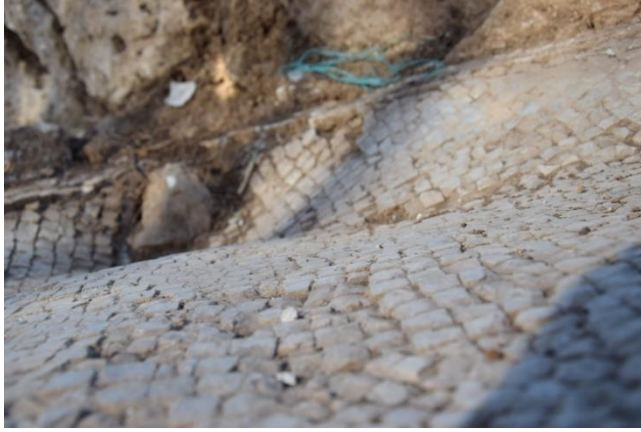
الشكل 4:79، شكل الهبوط بارضية الفسيفساء . (المصدر): الباحث، 2016.
