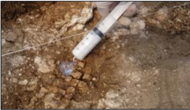
الشكل 4:76، عملية التدعيم الكيميائي، مشكلة انفصال الفسفساء عن الملاط. (المصدر): الباحث، 2016
