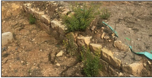
الشكل 4:112، حجارة الجدار الخارجي من الجهة الغربية، الكنيسة الشرقية، خربة الطيرة. (المصدر): الباحث، 2017.
