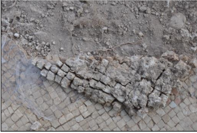
الشكل 4:75 معالجة مشكلة انفصال الفسفساء عن الملاط، خربة الطيرة. (المصدر): الباحث، 2016.
