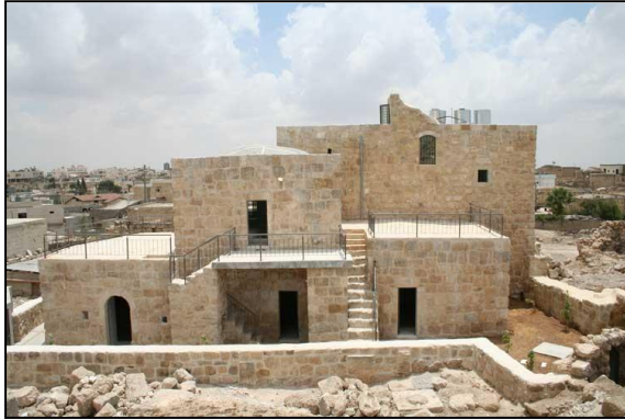
حالة المبنى بعد الترميم
