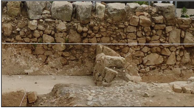
الشكل 4:106، يبين حجارة البناء من الداخل، كنيسة خربة الطيرة الغربية. (المصدر): الباحث، 2016.
