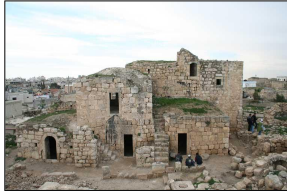
حالة المبنى قبل الترميم
