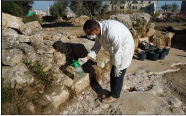
الشكل 72:4، عملية إشباع الجدران بالمادة الكيميائية. (المصدر): الباحث، 2016.
