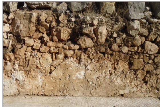
الشكل 104:4، طبقة القصاره قبل الترميم، الكنيسة الغربية، قرية الطيرة. (المصدر): الباحث، 2016.
