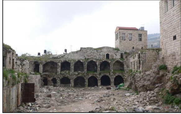
حالة المبنى قبل الترميم
