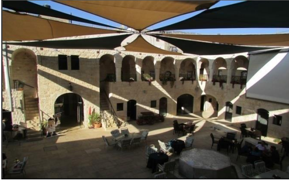
حالة المبنى بعد الترميم
