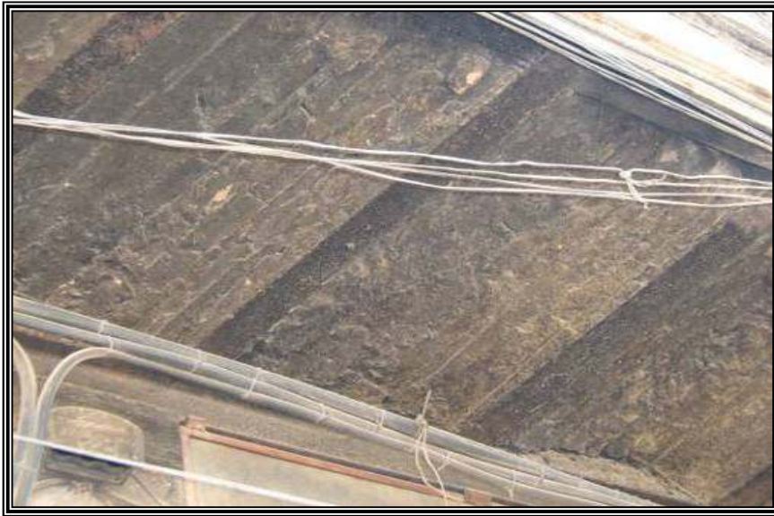
الصورة رقم "15.2": تظهر البناء بالدوامر والبلاطة الإسمنتية (2008)
