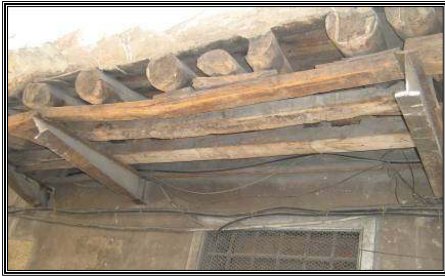
الصورة رقم "10.2": تظهر طريقة التسقيف بالدوامر الفولاذية التي تحمل الجسور الخشبية
