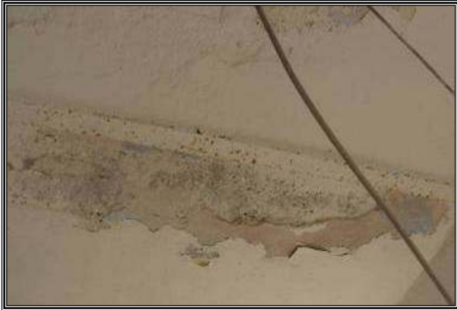
الصورة رقم "1.3": تظهر التشقق في المدة الإسمنتية فوق الدوامر وبداية ظهور الصدأ (2007)
