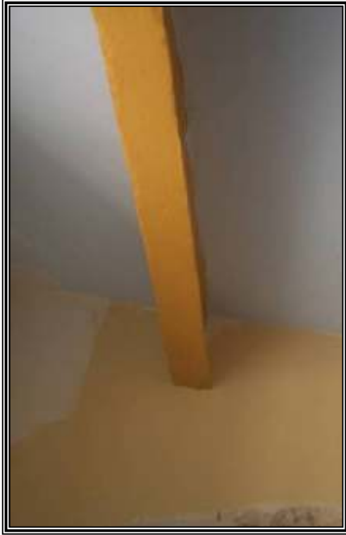
الصورة رقم "18.3": تظهر الدوامر التي كُشفت بعد ترميمها بإزالة المونة الإسمنتية فيما بينها (المصدر: مركز حفظ التراث، 2008)
