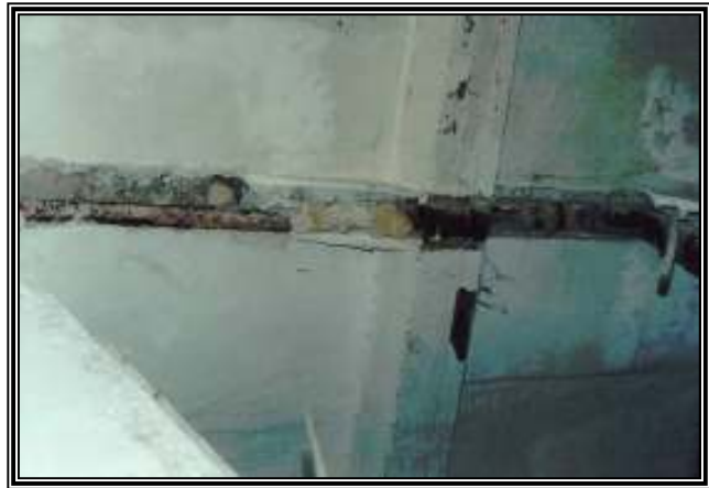
الصورة رقم "8.3": تظهر استخدام عوارض أسفل الدوامر لتقليل مسافة بحرهما (المصدر: لجنة اعمار الخليل، 2008)
