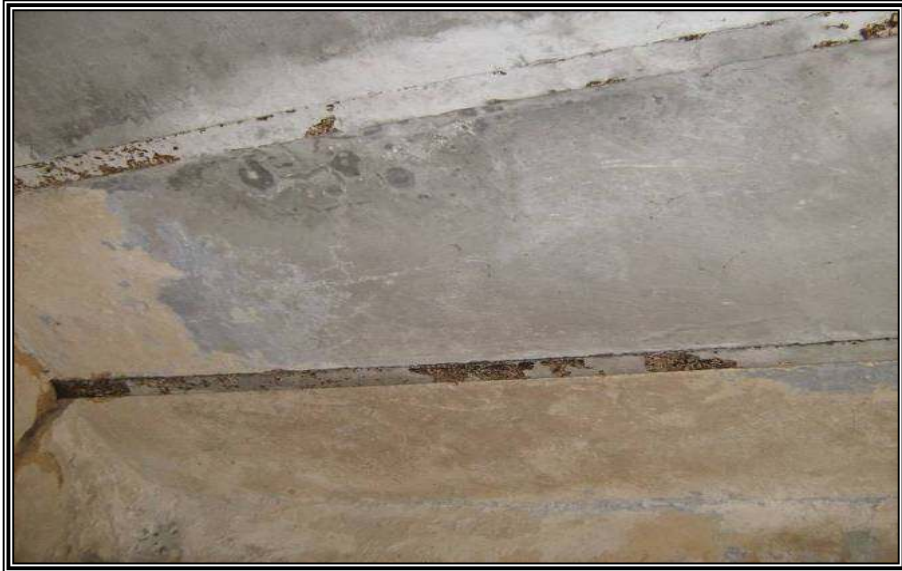
الصورة رقم "5.3": تظهر الصدأ في الدوامر قبل الترميم (المصدر: لجنة اعمار الخليل، 2008)
