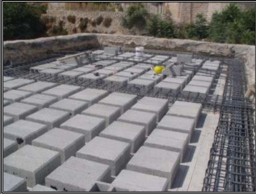
الصورة رقم "12.3": تظهر إنشاء السقف الجديد بالطرق الحديثة (المصدر: مركز حفظ التراث، 2008)
