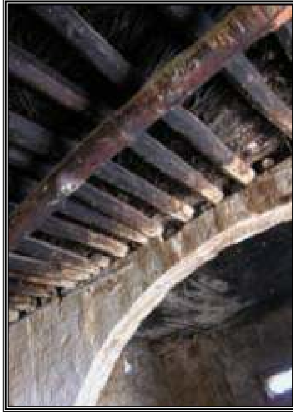
الصورة رقم "4.2": تظهر التسقيف بأغصان الأشجار المرتكزة على القوس (المصدر: سوريا، Corpus Levant، 2004، "سقف خشبي"، ص5)
