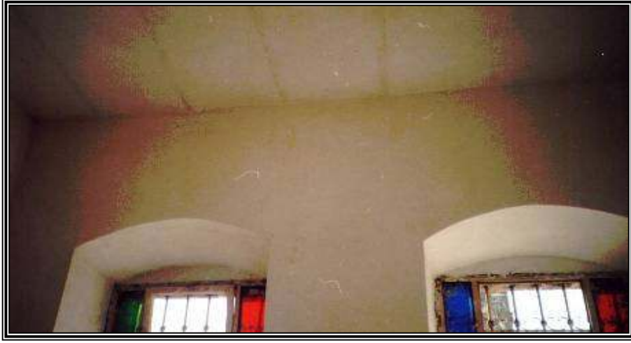
الصورة رقم "6.3": تظهر الدوامر بعد الترميم بإزالة الحمل الإضافي عن سطح المبنى ومعالجة الصدأ (المصدر: لجنة اعمار الخليل، 2008)
