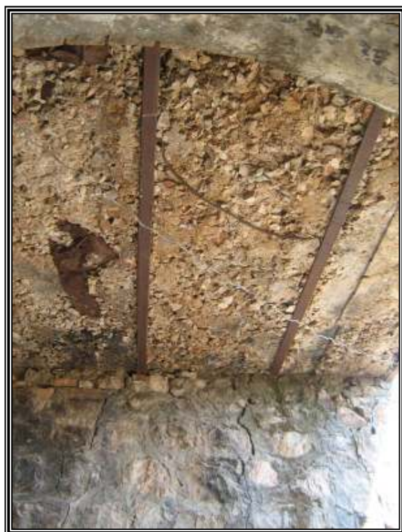
الصورة رقم "8.4": تظهر التلف في دوامر العينة الثانية (2009)
