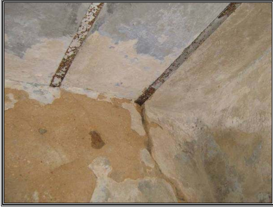
الصورة رقم "11.4": تظهر دواير العينة الثالثة التالفة (2009)
