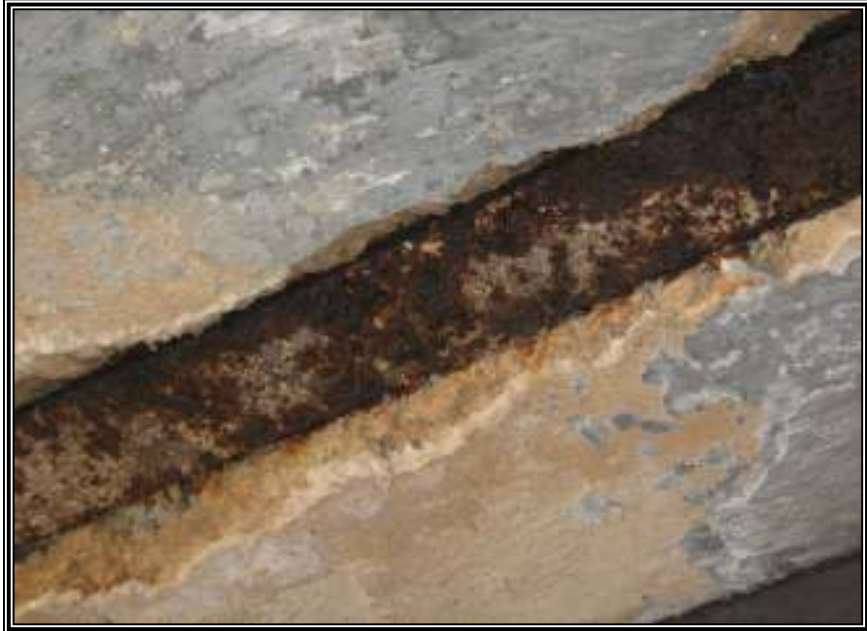
الصورة رقم "15.5": تظهر التلف الإنشائي للدوامر في العينة الثالثة (2009)
