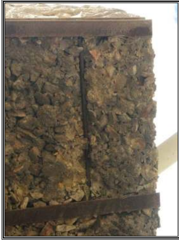
الصورة رقم "17.4": تظهر انكشاف الدوامر في مناطق مختلفة وبدرجات متفاوتة العينة الثانية (2009)
