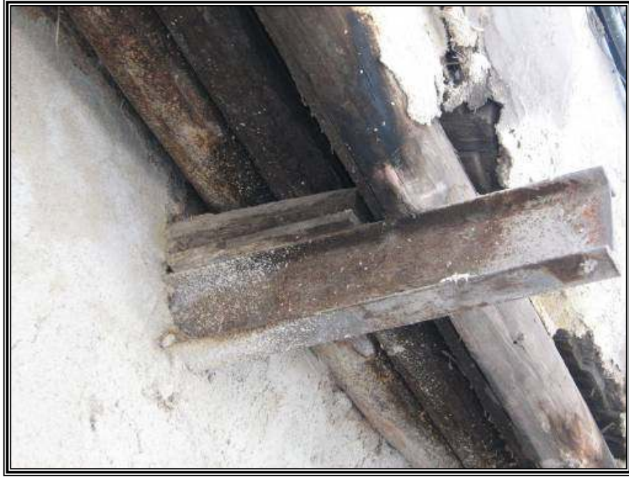
الصورة رقم "3.2": تظهر الجسر الفولاذي المستند على الجدار والحامل للجسور الخشبية (2008)
