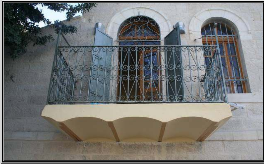
الصورة رقم "10.3": تظهر الدوامر بعد الترميم وتغيير المونة الإسمنتية فيما بينها (المصدر: مركز حفظ التراث، 2008)
