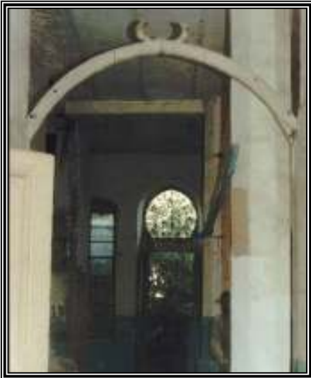
الصورة رقم "8.3": تظهر استخدام عوارض أسفل الدوامر لتقليل مسافة بحرهما (المصدر: لجنة اعمار الخليل، 2008)
