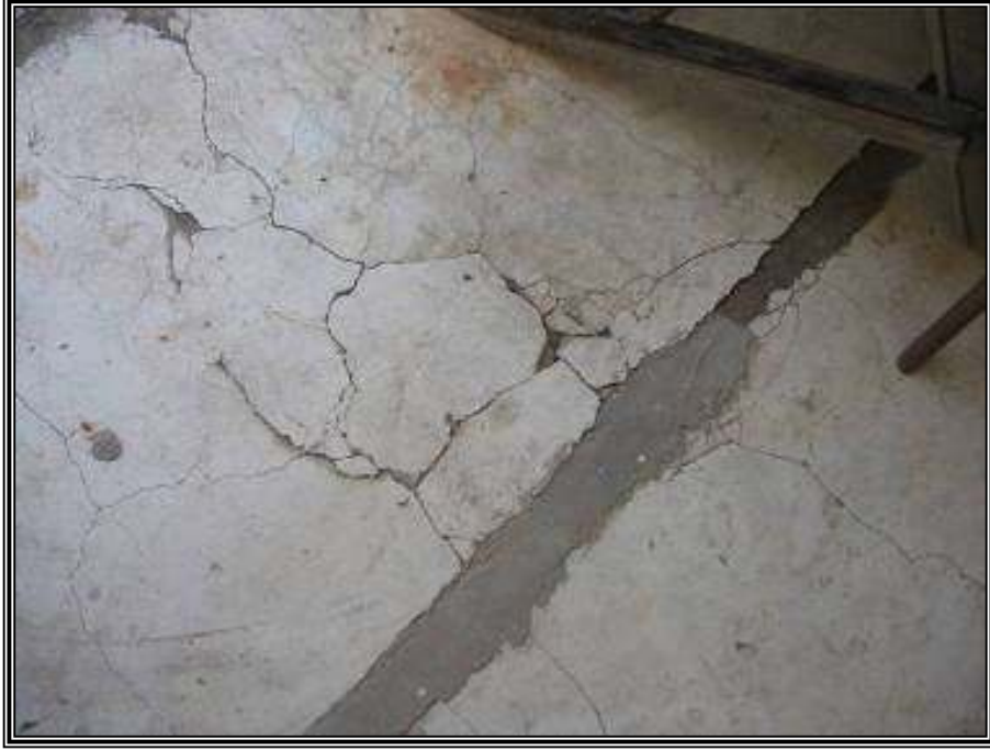
الصورة رقم "1.3": تظهر التشقق في المدة الإسمنتية فوق الدوامر وبداية ظهور الصدأ (2007)
