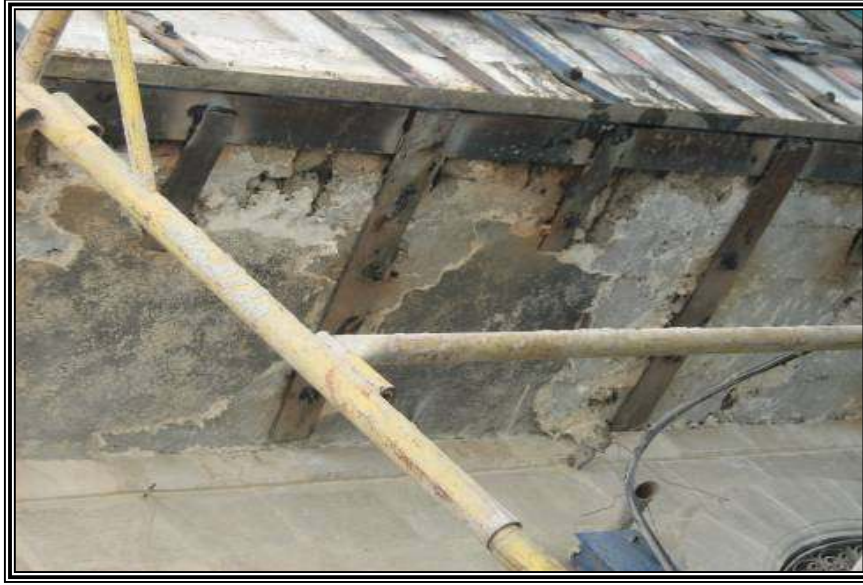
الصورة رقم "14.2": تظهر البناء بالدوامر والبلاطة الجيرية (2008)
