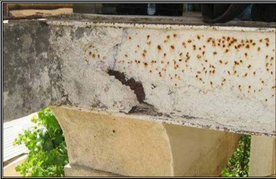
الصورة رقم "4.4": تظهر دوامر العينة الأولى "ب" المكشوفة والتي تعرضت للتلف (2007)
