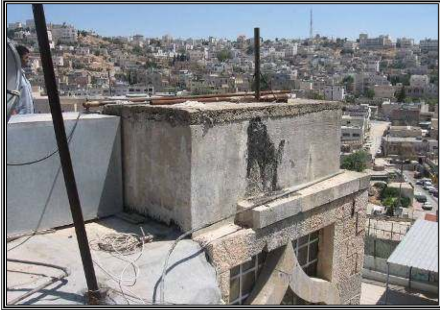
الصورة رقم "4.3": تظهر وجود الخزانات في السطح كحمل زائد عليه (2007)
