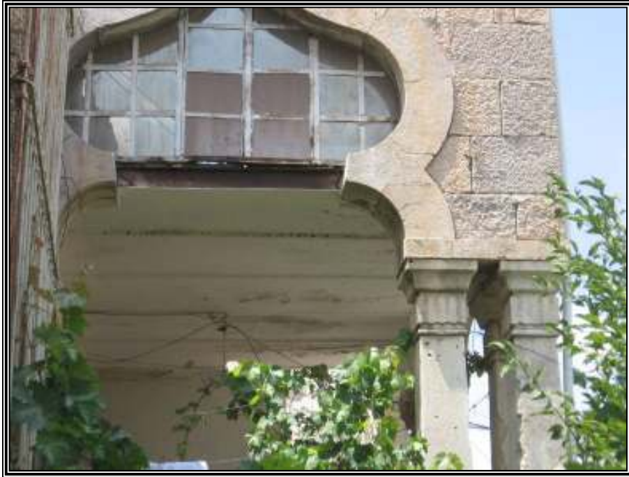
الصورة رقم "13.4": تظهر التلف الإنشائي للدوامر في العينة الأولى "ب" (2007)
