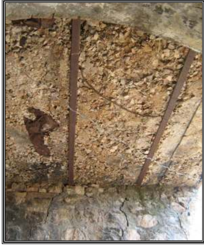
الصورة رقم "14.4": تظهر التلف الإنشائي للدوامر في العينة الثانية (2009)
