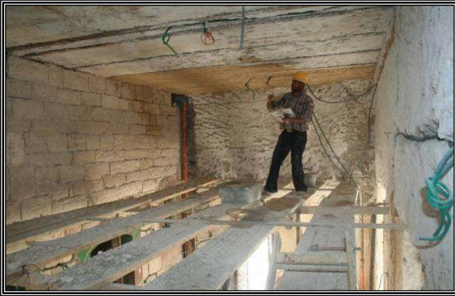
الصورة رقم "15.3": تظهر كيفية ترميم (Flange) الدوامر بعد إزالة القسارة (المصدر: مركز حفظ التراث، 2008)
