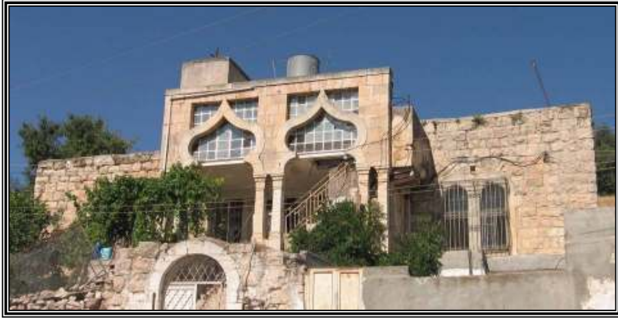
الصورة رقم "2.4": تظهر واجهة المبنى الأول (المصدر: ورشة عمل ميدانية، 2007)
