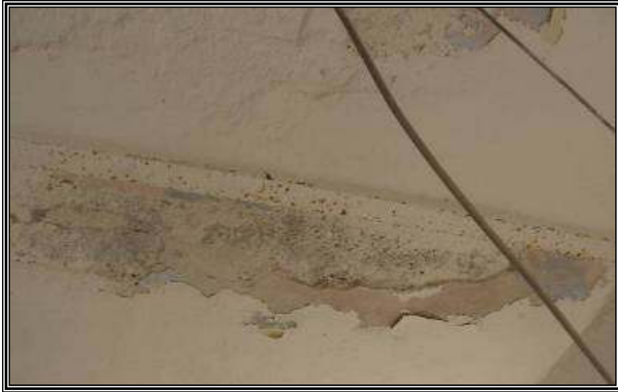
الصورة رقم "12.4": تظهر دوامر البرنדה- العينة الأولى "أ" التي تتعرض لبداية التلف - الصدأ (2007)
