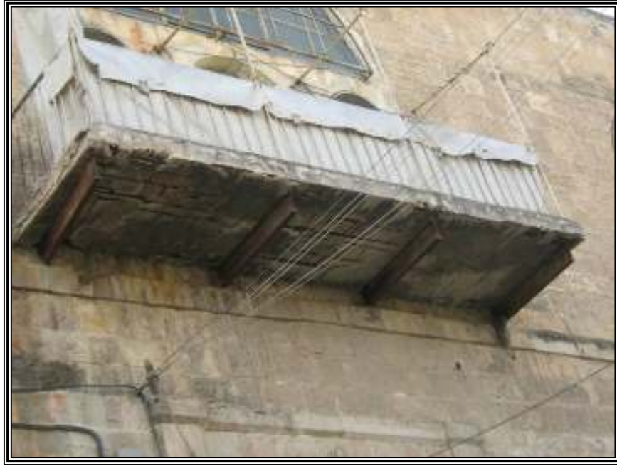
الصورة رقم "16.2": تظهر البناء بالدوامر أسفل البلاطة الإسمنتية (2008)
