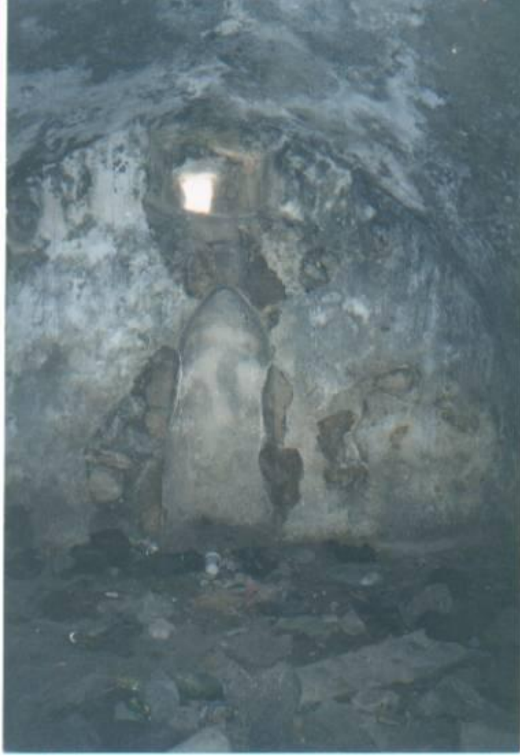
شكل 99: الواجهة الجنوبية لمقام ابو عتاب في مدينة سلفيت من الداخل. تصوير الباحثة، 2003.
