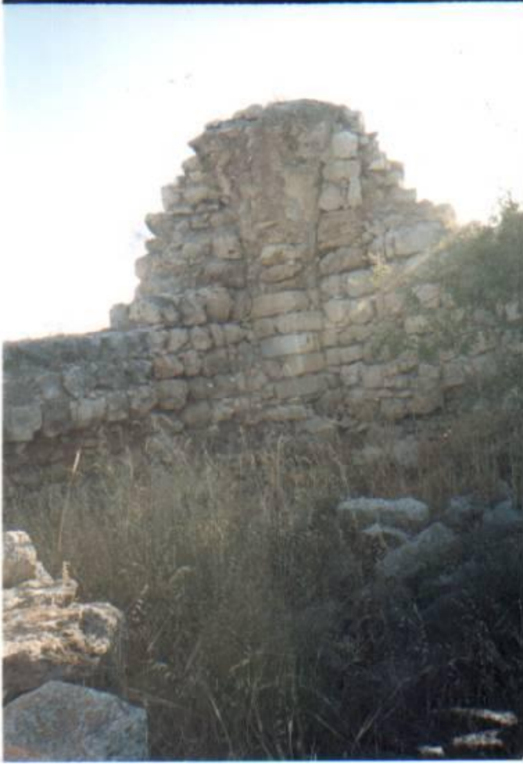
شكل 19: بقايا احد الابنية المقامة على خربة جلال الدين في قرية بروقين. تصوير الباحثة، 2003.
