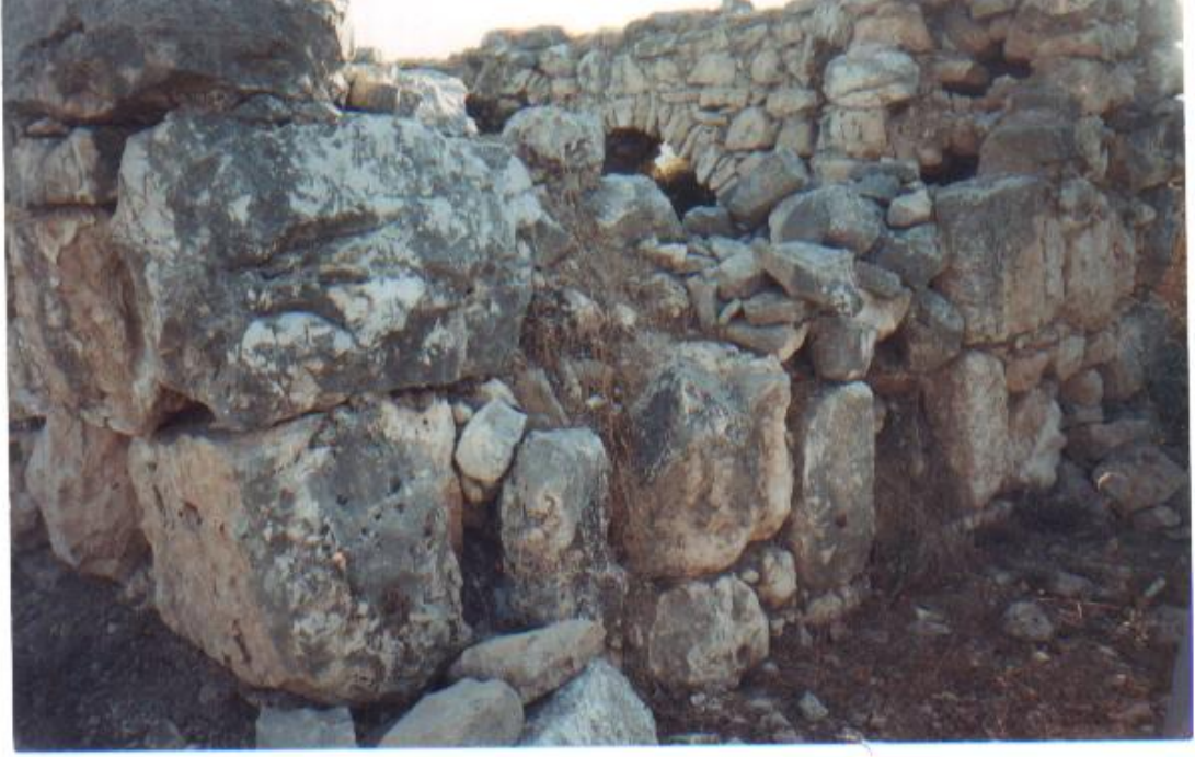
شكل 87: بقايا مقام الشيخه نفيسه في قرية قيروه. أ. مسقط افقي للمقام. ب. الواجهه الشماليه . رسم: م. حمدان ابو سمره، A-A.2003 للمقام. ج. مقطع
