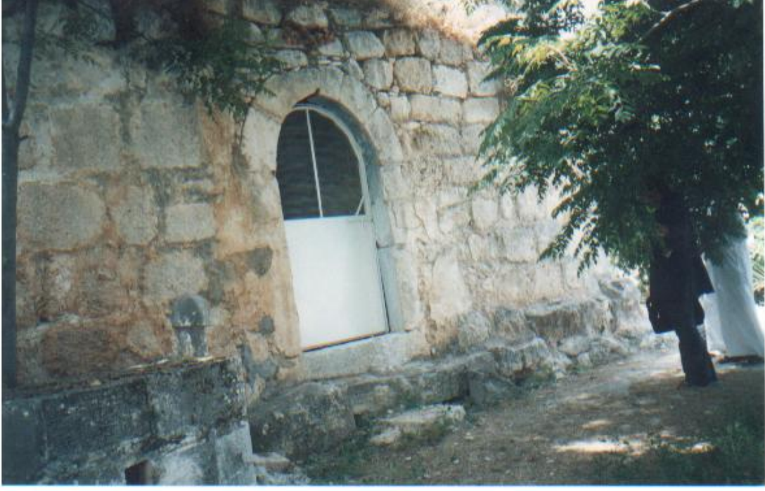
شكل 109: مقام الشيخ ابو عطاق في كفر الديك . ويظهر الباب في الواجهة الشمالية. تصوير الباحثة، 2003.
