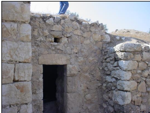
شكل رقم (66:6) صورة المدخل للغرفة الثانية المصدر: الباحث 2005
