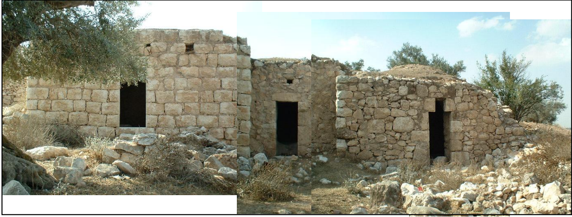
شكل رقم (63:6) صورة منظر عام للمبنى المصدر: الباحث 2005
