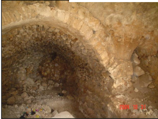
صف التفصيلي: المسقط الأفقي للمبنى شبه منحرف هذا غريب بالنسبة للمنازل القديمة (لاحظ شكل رقم (33:6))، يقع المدخل في الجهة الجنوبية (لاحظ شكل رقم (34:6))، وهو عبارة عن باب مستطيل الشكل (D1) ذو عقد مستقيم وهناك فتحة على شكل نصف قوس مدبب الرأس تفتح في الجهة الغربية للمبنى ربما كانت تستخدم كمدخل آخر أو أن هناك جزء مهدم أو أن المبنى كان ذو استخدام عام ويحتاج إلى واجهة مفتوحة، ومستواها أعلى من فتحة الباب (لاحظ شكل رقم (35:6)).
