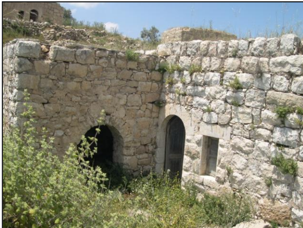
شكل رقم (82:6) صورة منظر عام للمبنى المصدر: الباحث 2005
