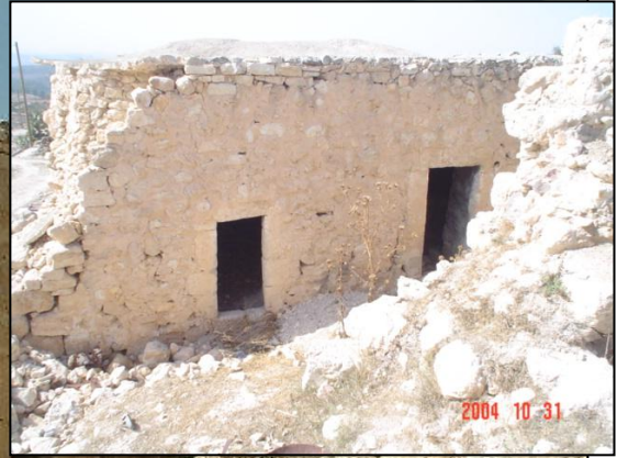
صورة رقم ( 12:6) صورة الواجهة الشرقية للمبنى المصدر: الباحث 2005
