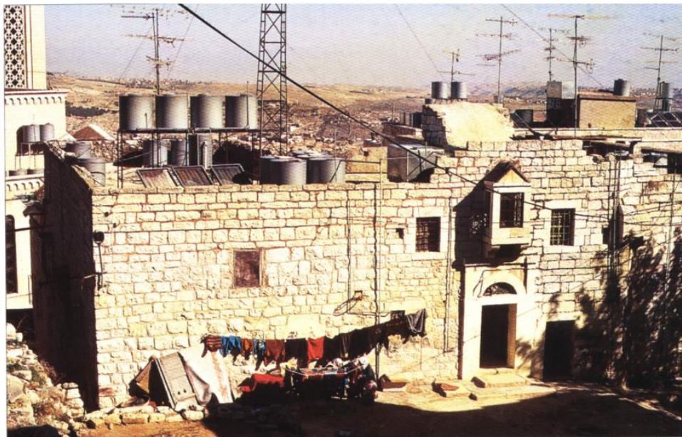
لوحة (45-4): الواجهة الجنوبية
