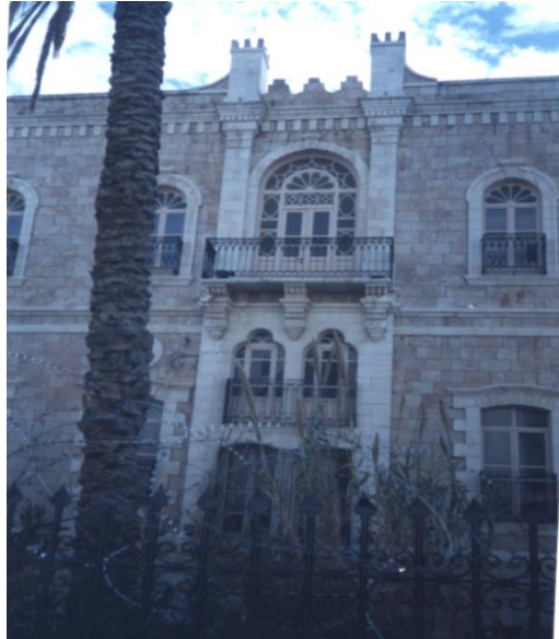
لوحة (4-56) : الواجهة الشمالية
