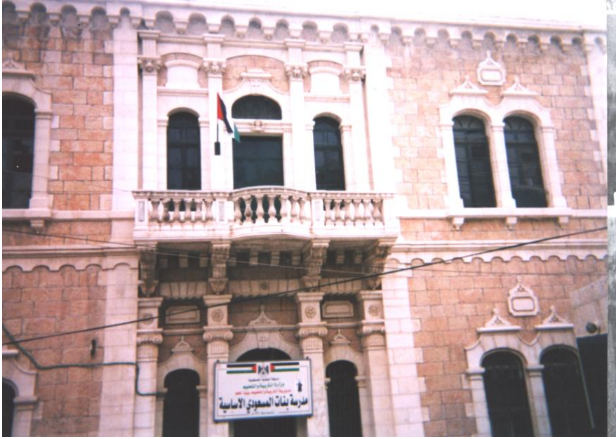
لوحة (4-27) الواجهة الشمالية
