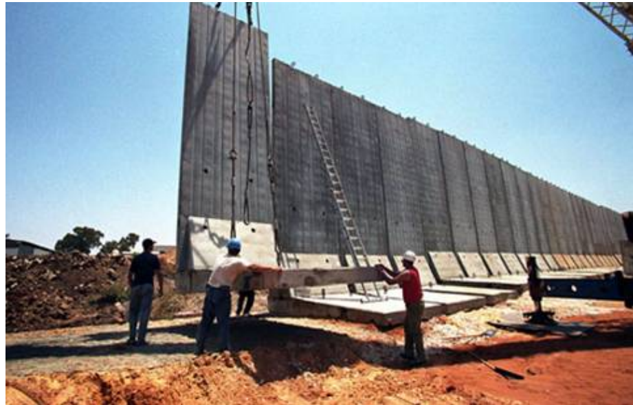
صورة 10: بناء الجدار الفاصل العنصري حول القدس 2003
