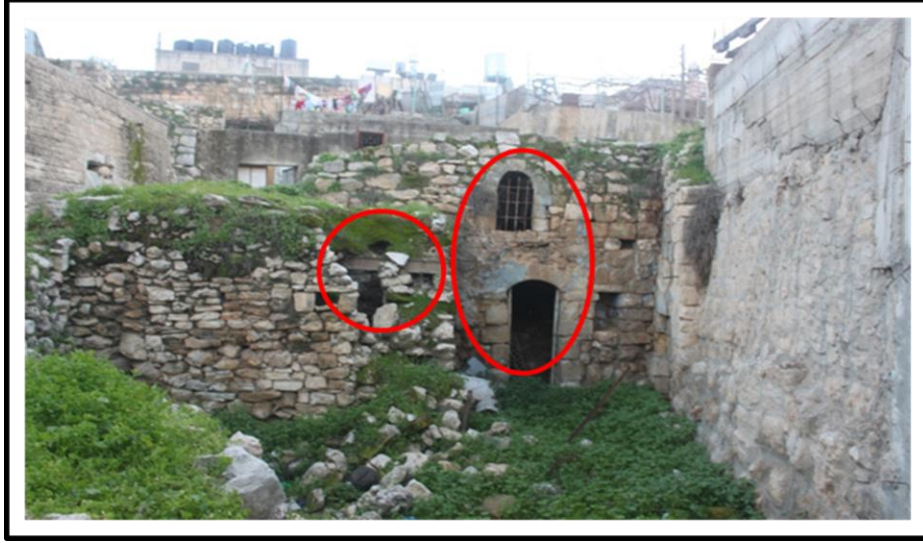
شكل 5.4: إستخدام الحديد في العقد والنوافذ، حوش دار ابو العواد عصفور.المصدر: الباحث، 2012.
