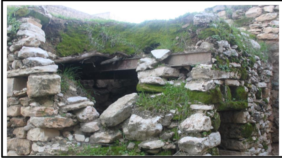
شكل 24.5: عقد مستوي بنظام الدوامر الحديدية والأخشاب، بيت أبوالعواد عصفور، المصدر: الباحث، 2013.
